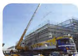
プラント建設工事
