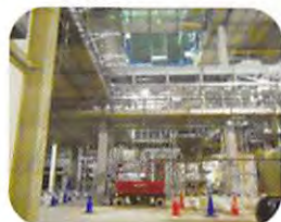
電気計装工事
