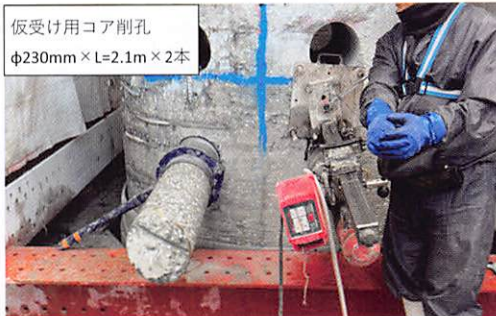
既存杭 φ2100mm L=18.50m W=102.1t アンカー2本打設
